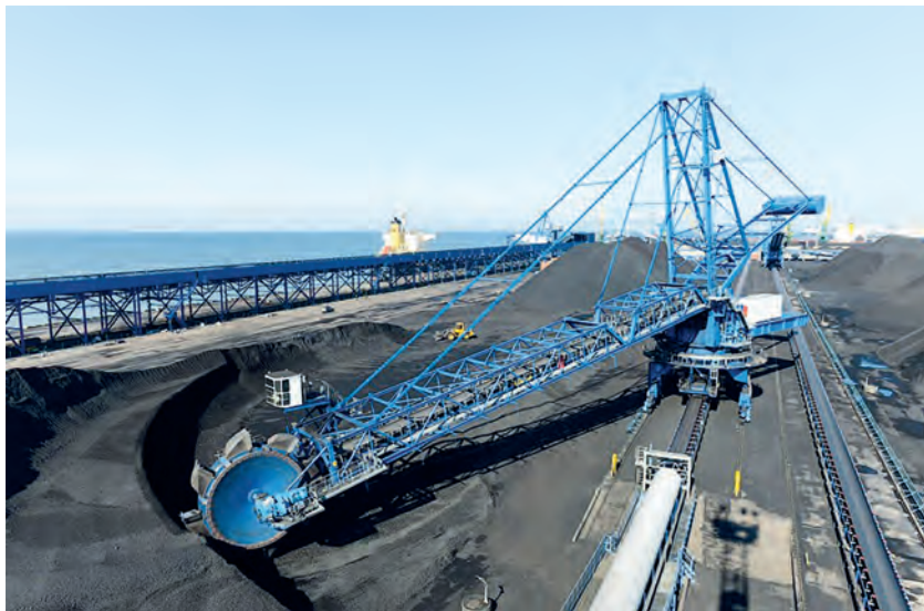
Рис. 4. Комбинированный заборщик-укладчик (стакер-реклаймер) на угольном терминале в морском порту Усть-Луга
