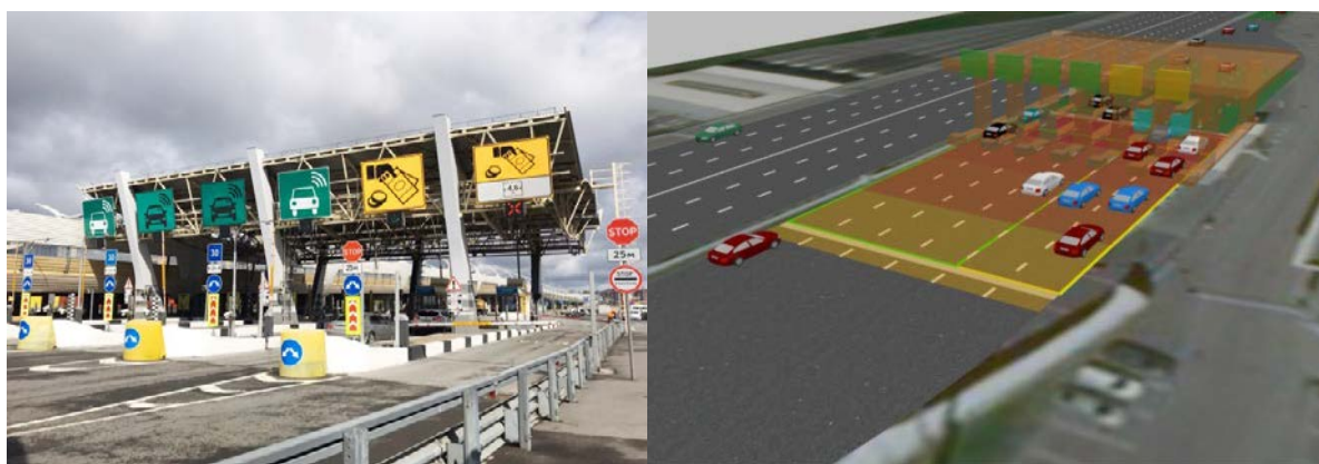
Рисунок 1. Общий вид объекта – оригинала и имитационная модель ПВП на съезде платной дороги
