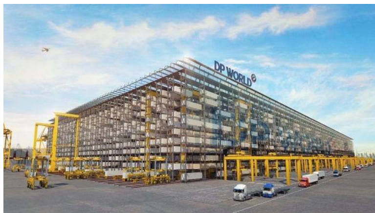
Рис. 2 – Стеллажное хранение контейнеров
